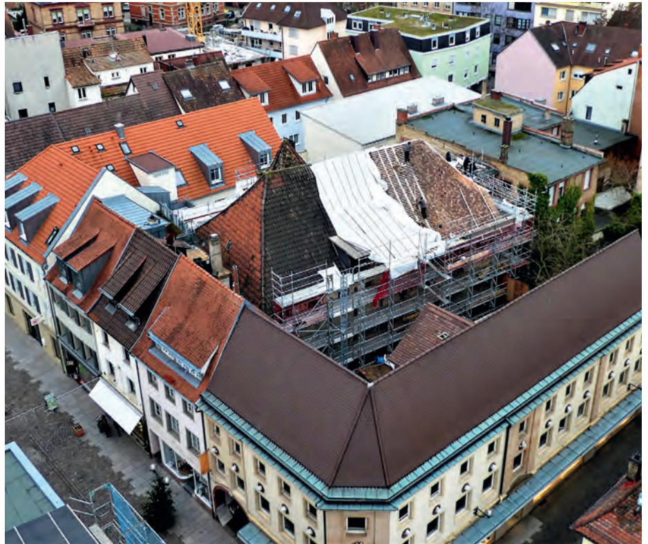
Das Haus zum Maulbeerbaum während der Sanierung.
